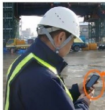
スマートフォンによる打設状況の確認
