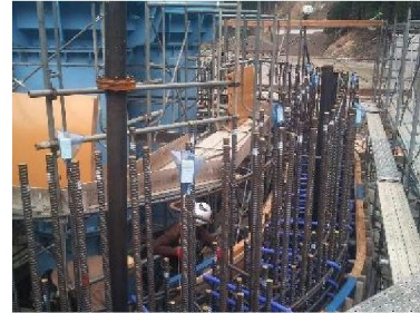
現場での設置状況
